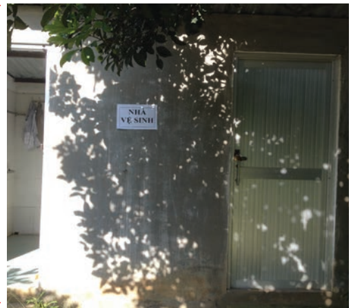
Hình 10. Nhà vệ sinh tự hoại
